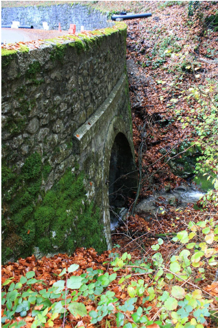
Pont de Trélachaud, tympan amont
