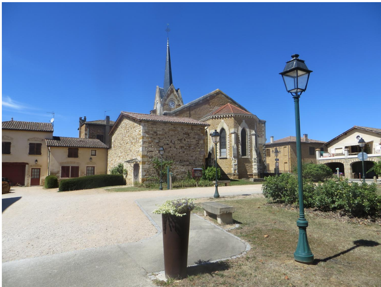
Vue de situation depuis le square du Souvenir
