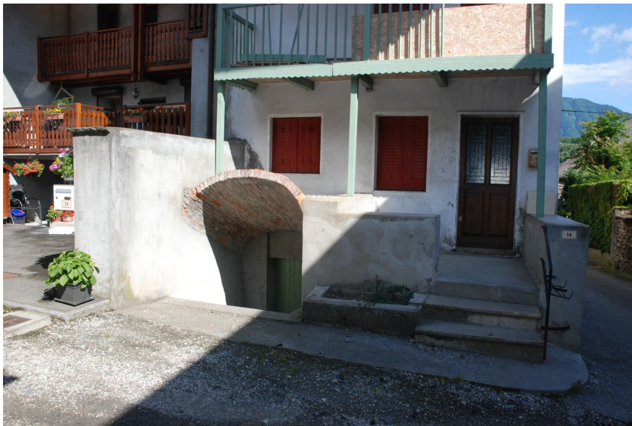
Maison de vigneron (2018 D3 1917). Descente de cave sous une voûte en brique.
