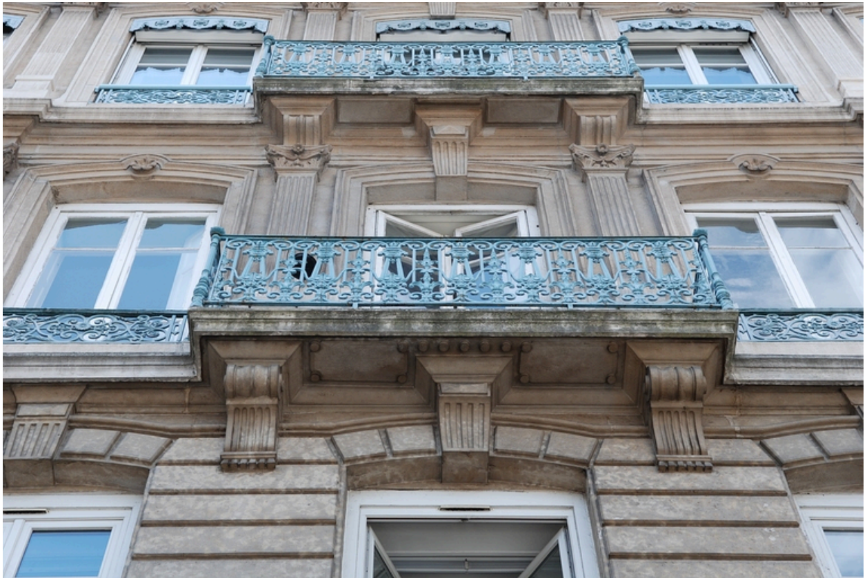
Elévation place des Jacobins : détail des balconnets
