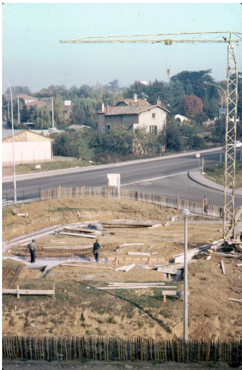
Début du chantier de la chapelle de la Sauvegarde, fin 1972
