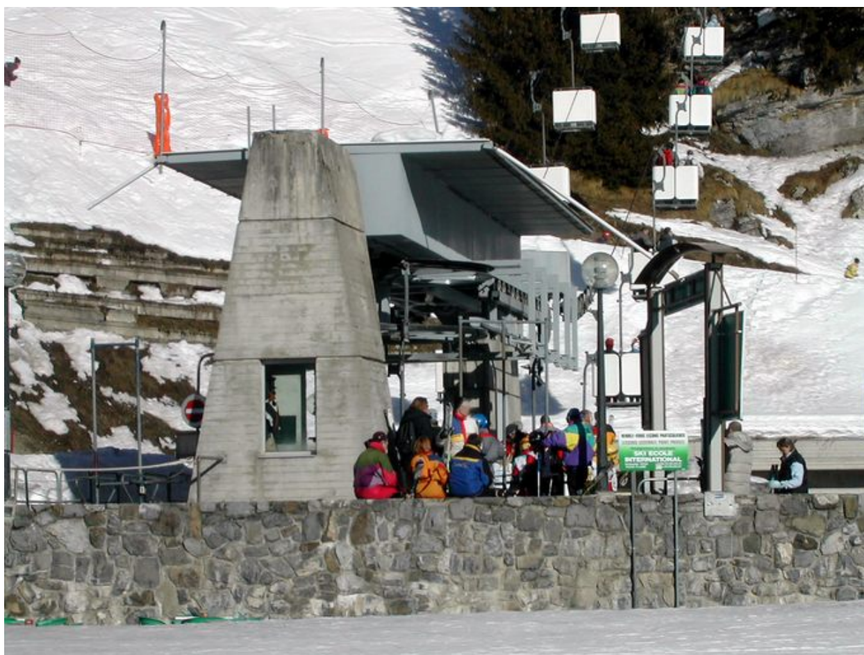
La gare inférieure de la télébenne des Grands Vans
