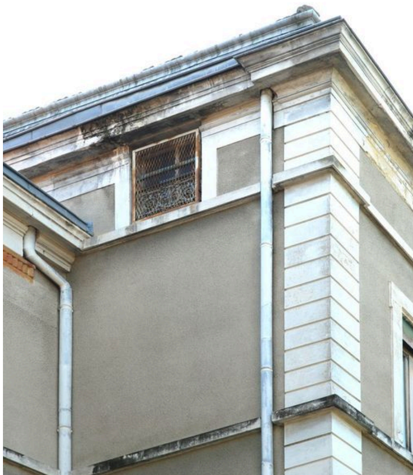
Détail de l'avant-corps central, bâtiment 504, façade postérieure (ouest) : garde-corps en fer forgé
