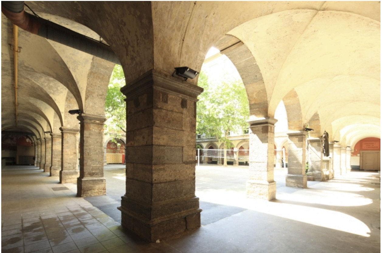
Cour du lycée. Angle sud-ouest.
