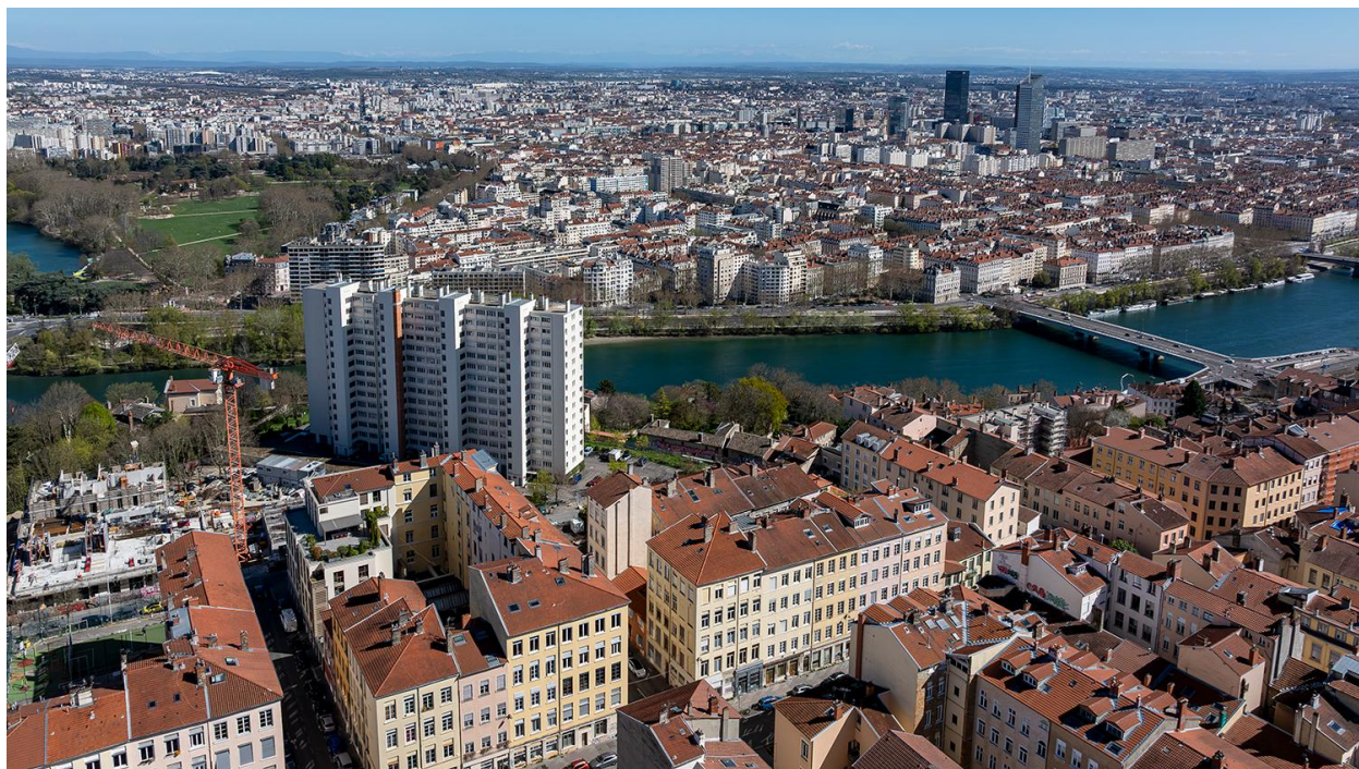
Vue d'ensemble secteur des immeubles-ateliers (vue drone)
