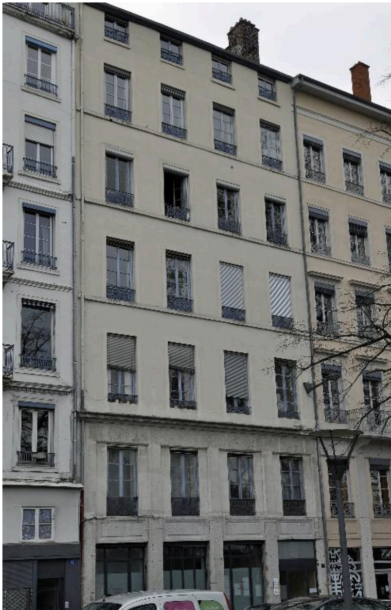
Vue générale, élévation sur rue
