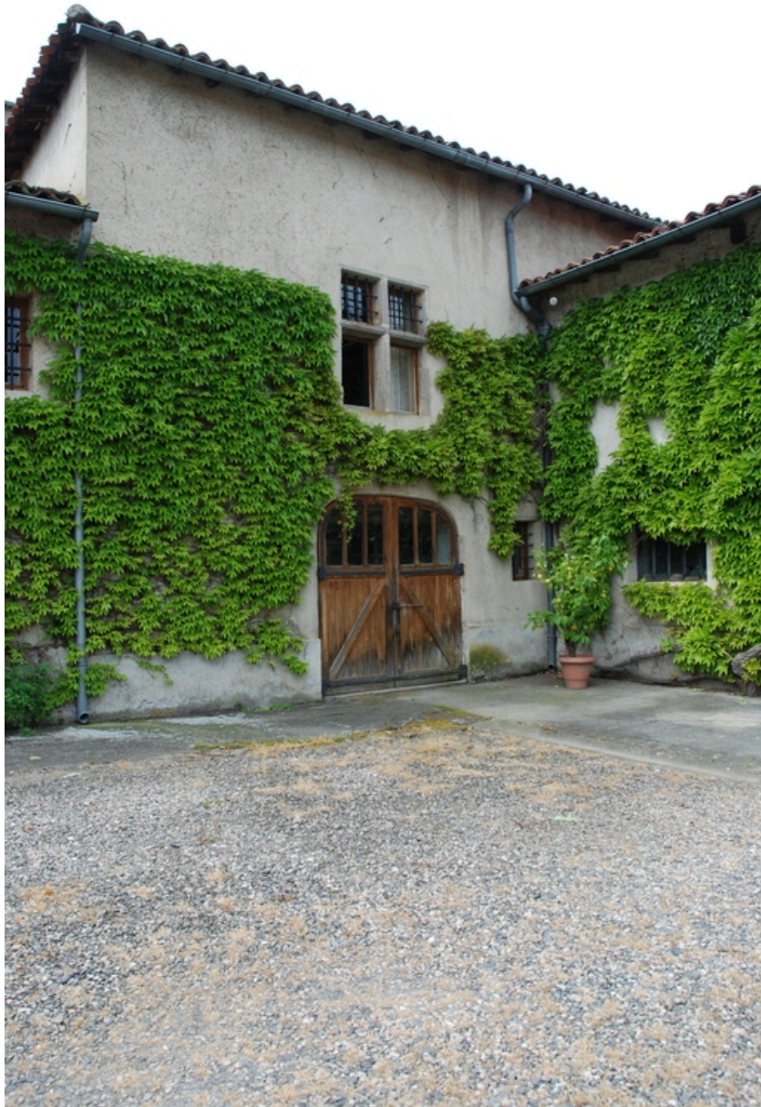
Vue du bâtiment sud-ouest, depuis la cour.
