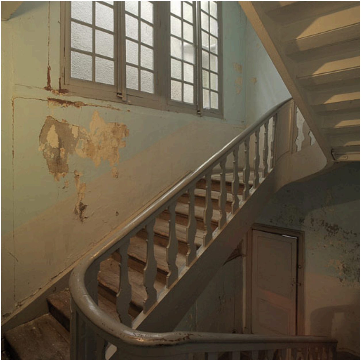
Vue partielle de la cage d'escalier.
