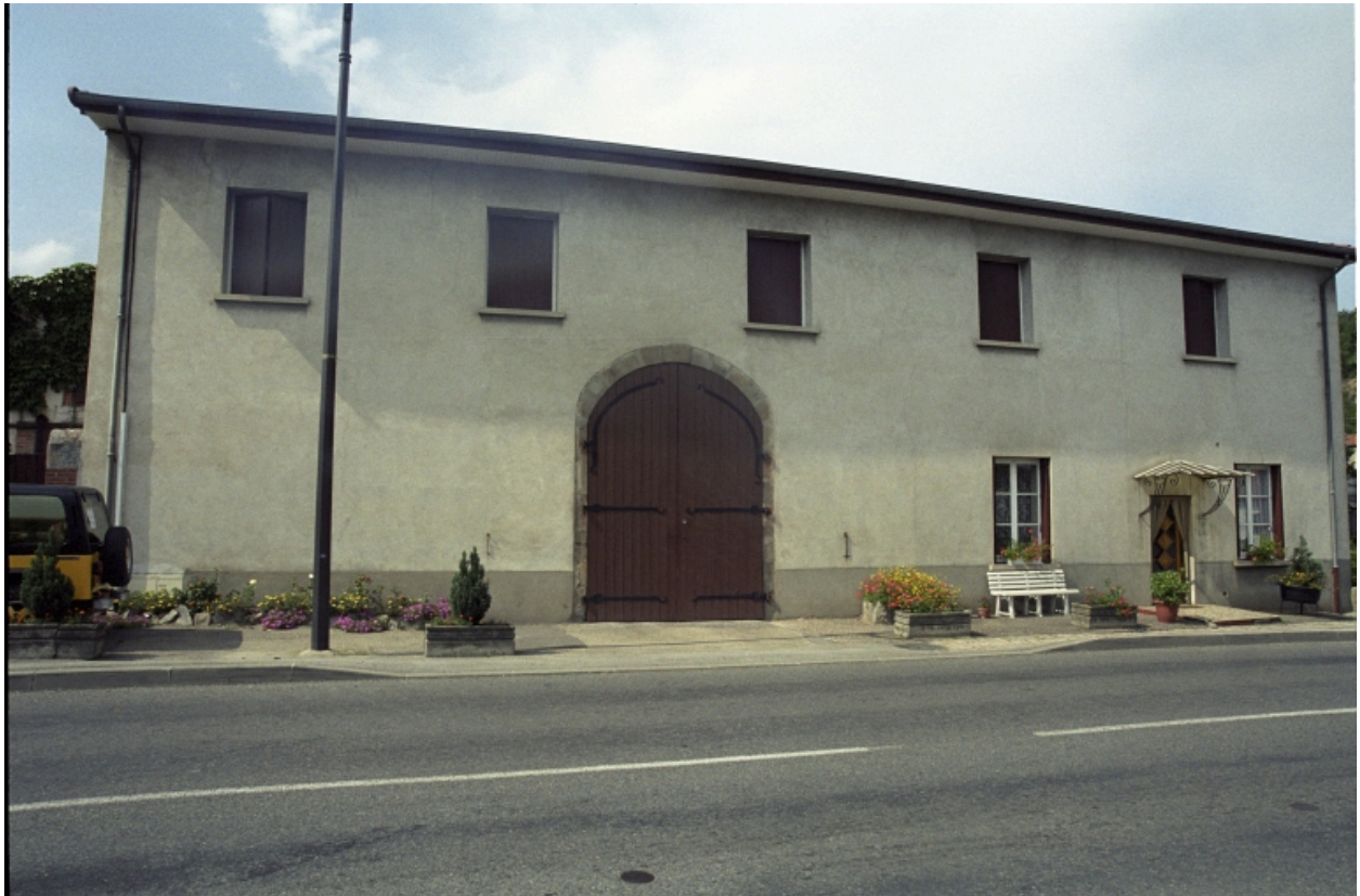
Vue d'ensemble du logis et du cuvage depuis la route.
