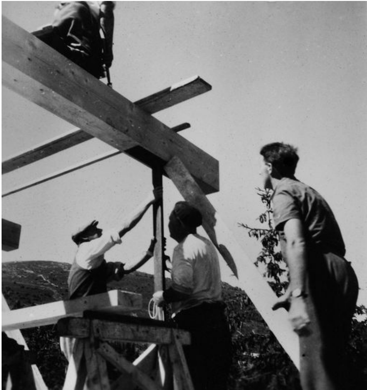
Denys Pradelle (à droite) sur le chantier de construction. Photogr., [1950] (AD Savoie. 6J 100)
