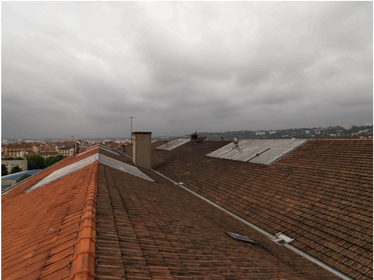
Vue des toits à longs pans
