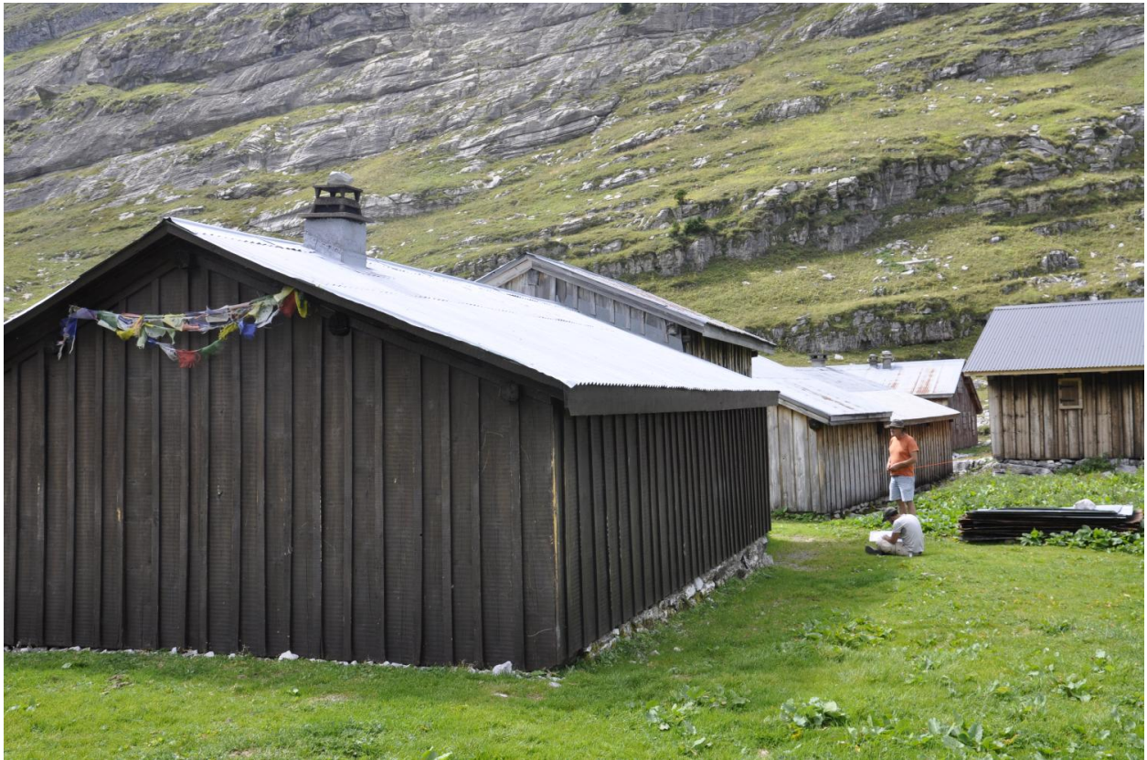
Vue de l'élévation nord-est
