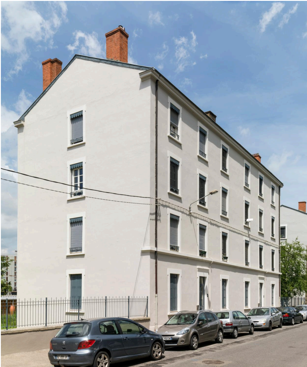
Détail pignon nord
