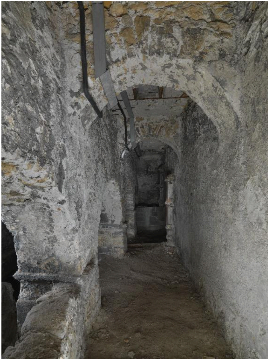
Sous-sol de l'aile des cuisines : vue du couloir latéral
