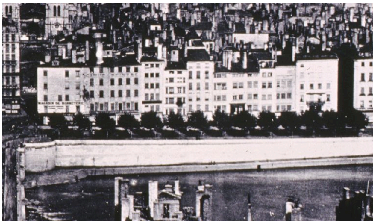
Vue générale de l'ancien quai de Villeroy, détail d'une fotogr., 1857-1858
