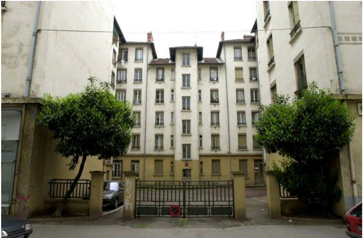
La cour des 32-34 rue Quivogne, depuis la rue
