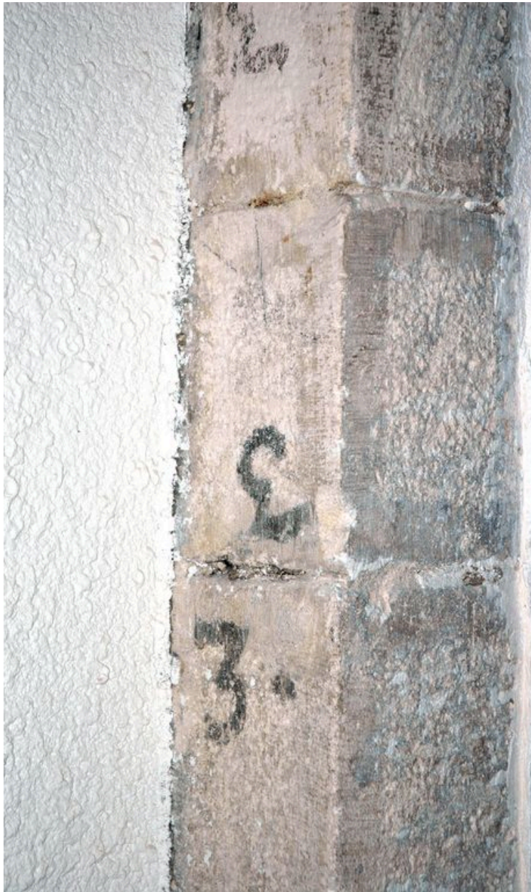
Marques de pose, encadrement de porte murée, 2e étage
