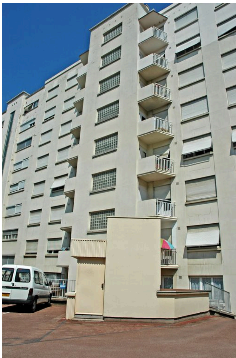
Elévation postérieure : la cage d'escalier demi-hors-oeuvre
