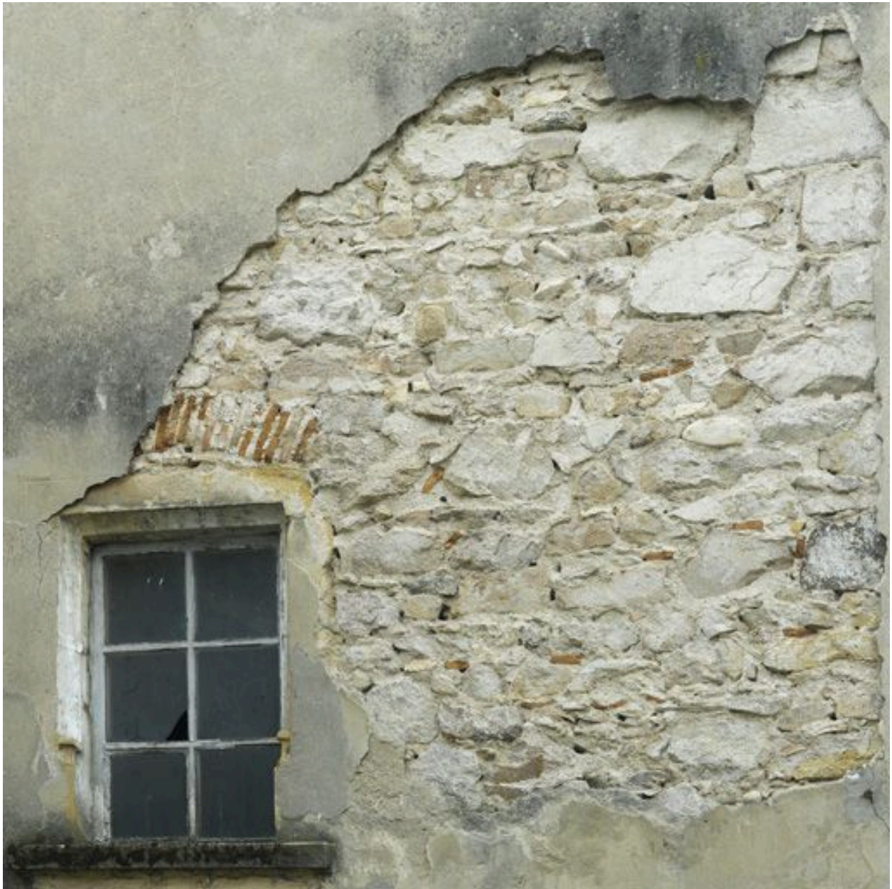
Façade est. Tour sud-est. Détail des matériaux
