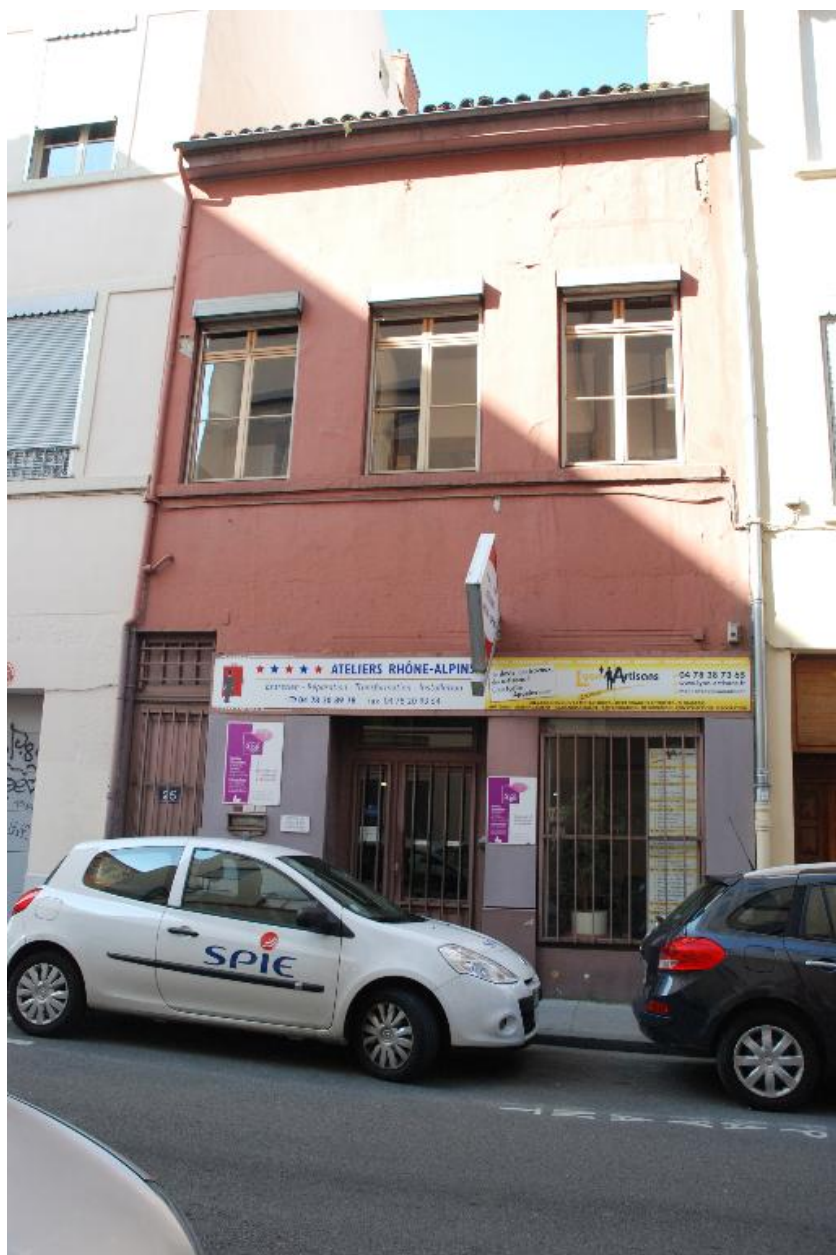
Vue d'ensemble nord est
