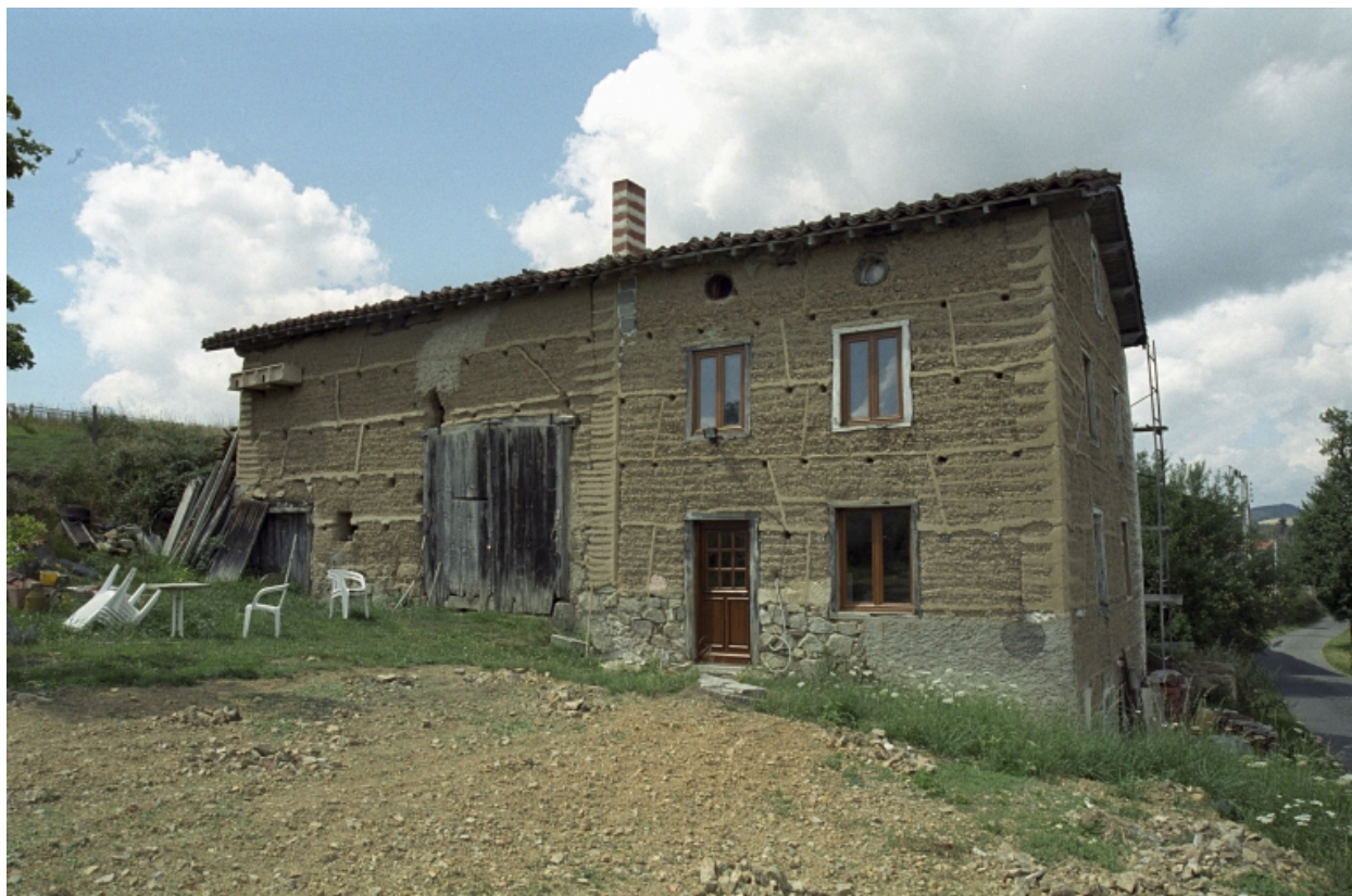
Saint-Laurent-Rochefort, Serre, ferme (1987 A2 1215). Vue d'ensemble (milieu 19e siècle).
