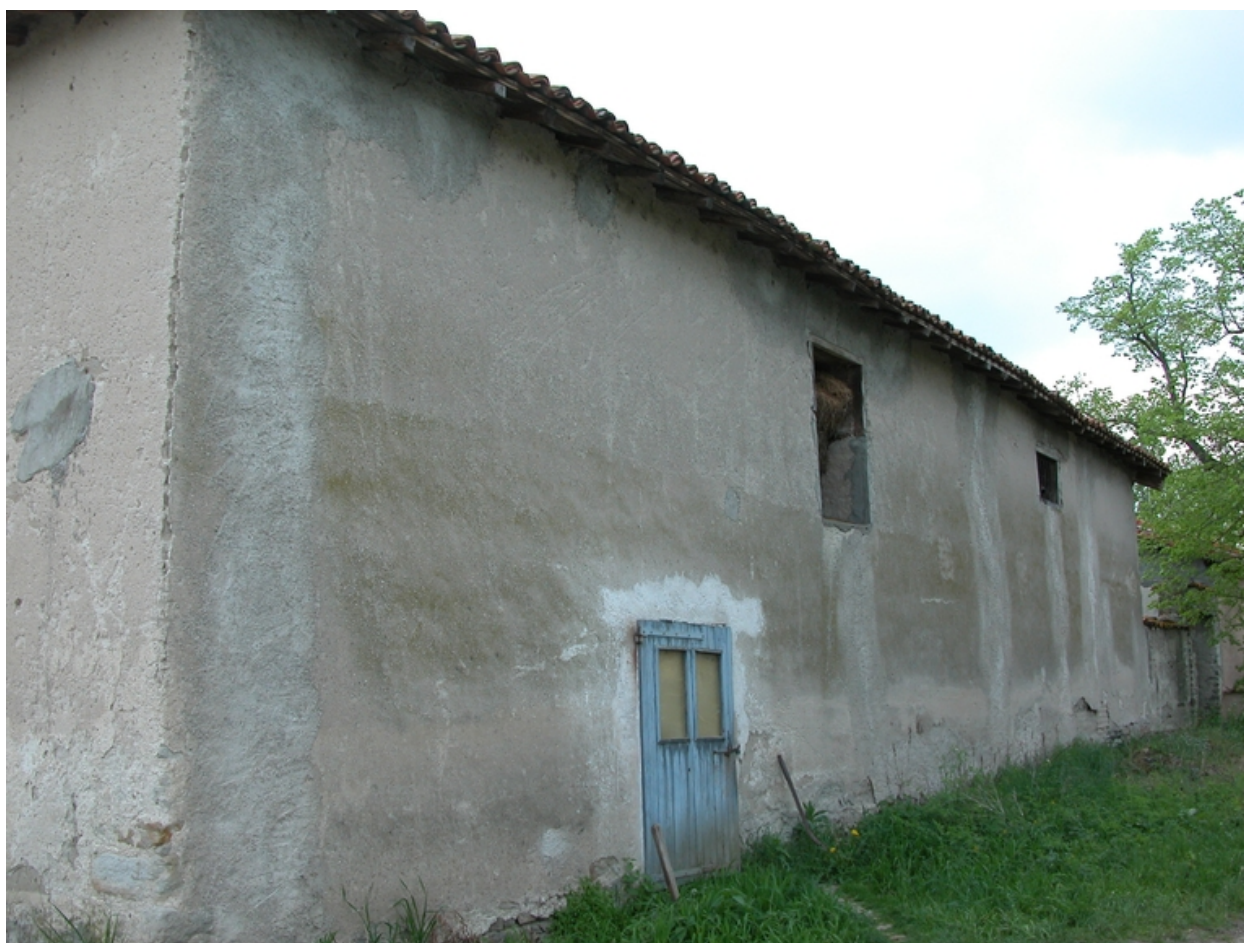
Vue de l'élévation nord de la grange-étable.
