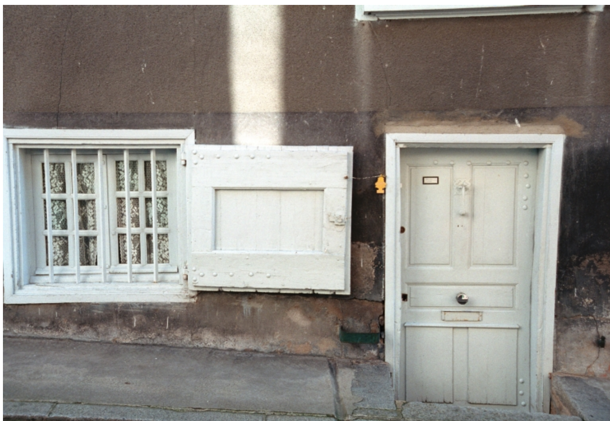
Boën, îlot 13, Ph. Raymond (rue) 20. Détail huiseries de la façade sur rue.
