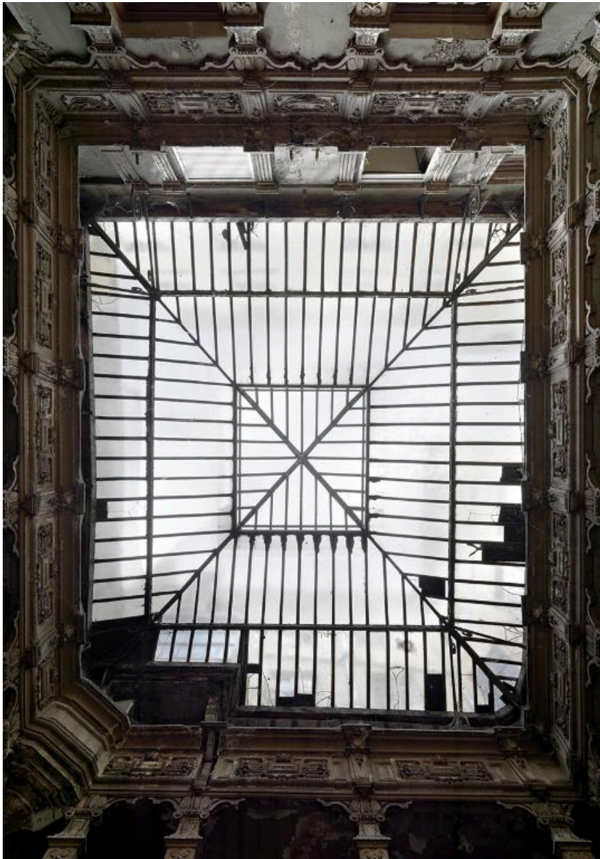
Cour, verrière zénithale, vue générale
