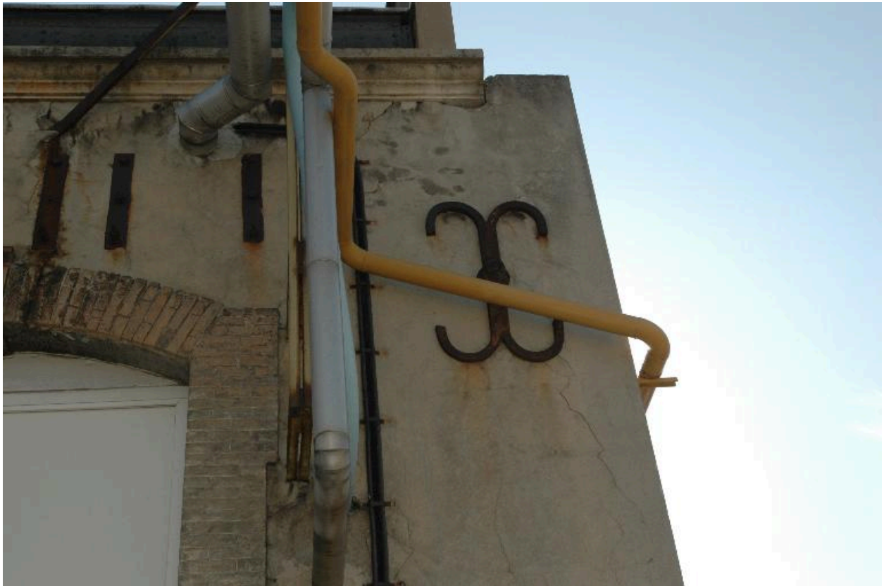
Détail d'une facade
