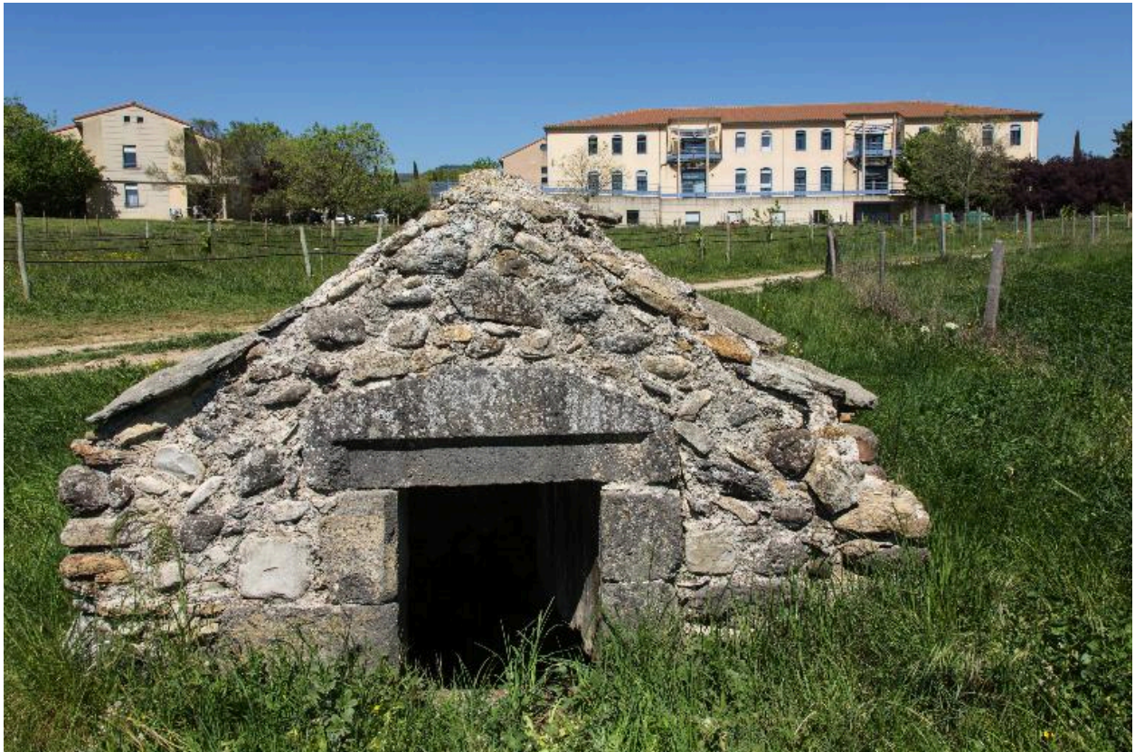
Mère des fontaines : entrée côté sud
