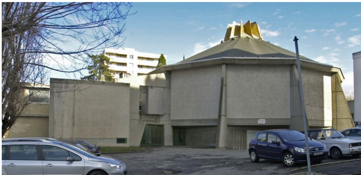
Vue du chevet de l'église depuis le sud-ouest
