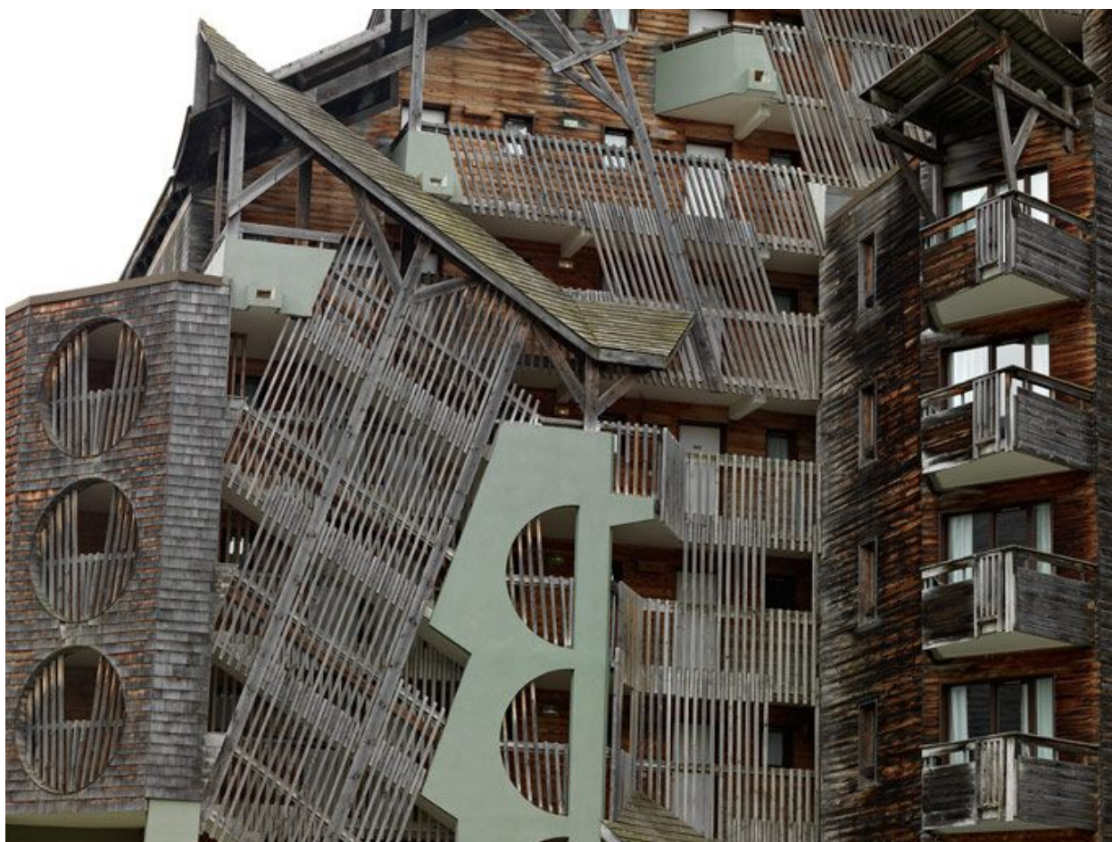
Détail de la façade nord
