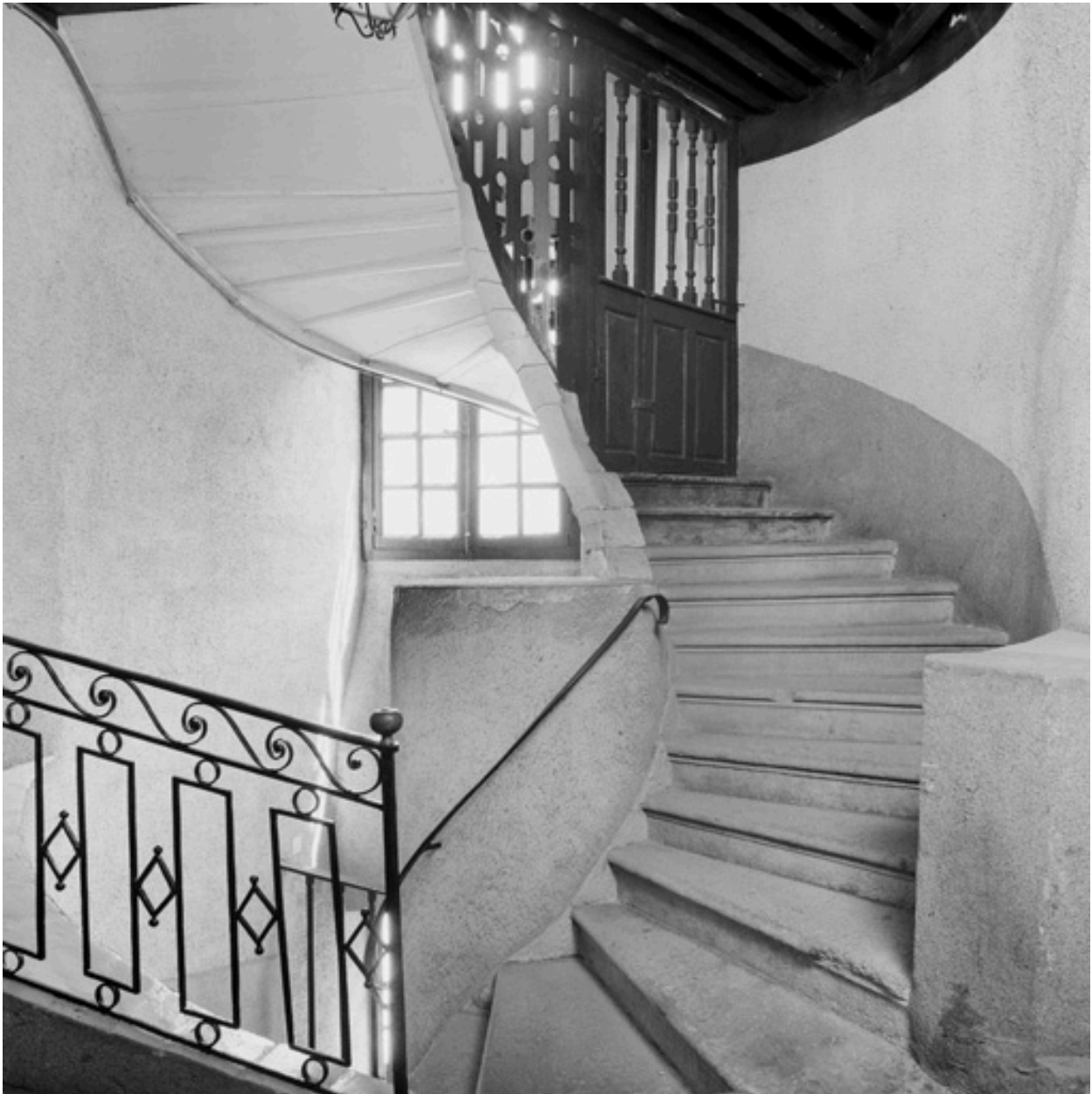
Escalier en vis, partie haute modifiée au 19e siècle.
