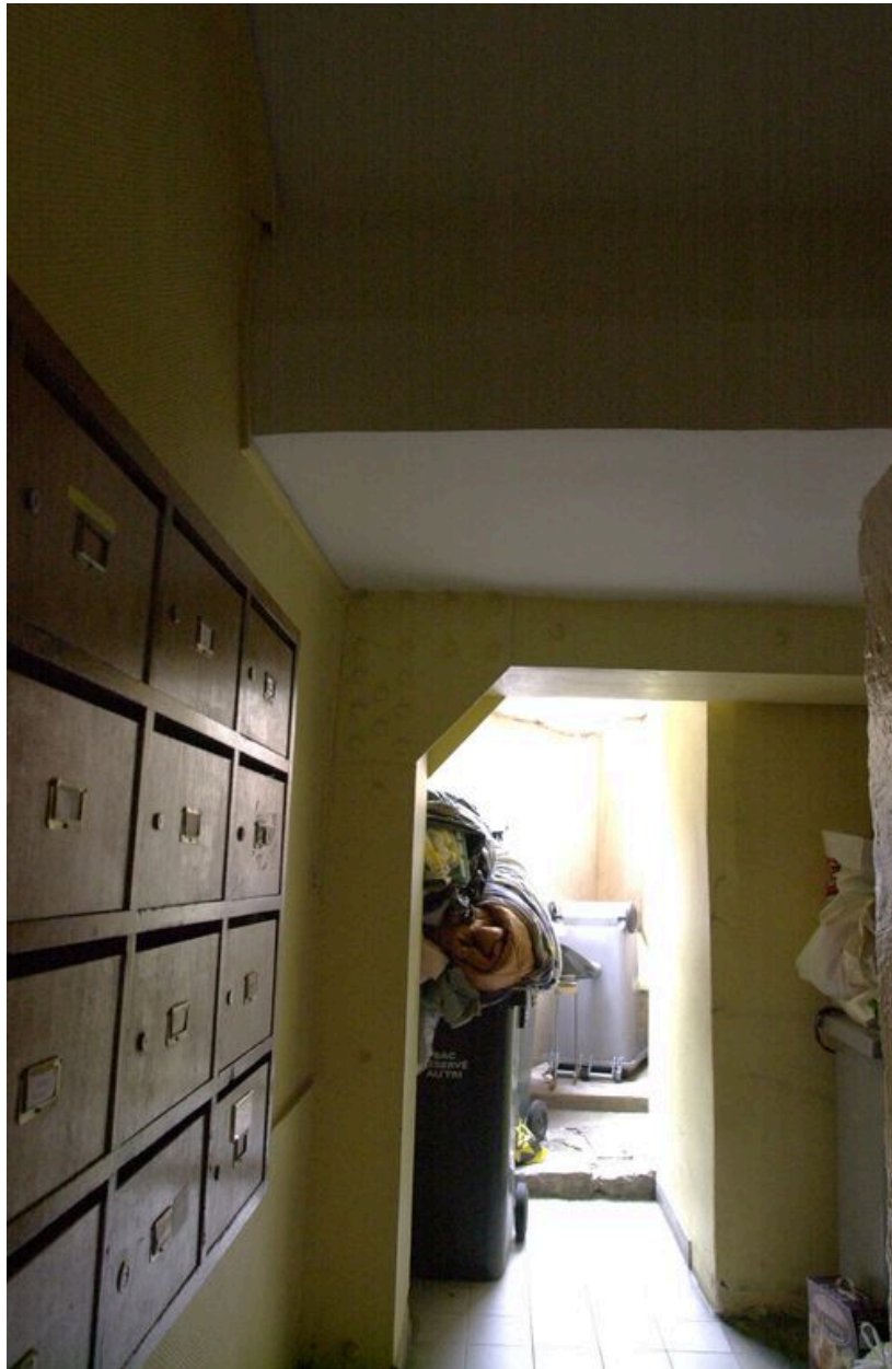
Le couloir d'entrée et la sortie vers la cour
