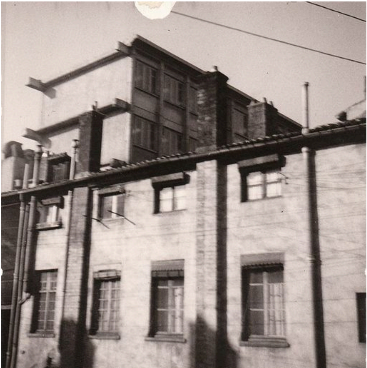
Bâtiments sur cour avant démolition, photographie ancienne, 1970-1971
