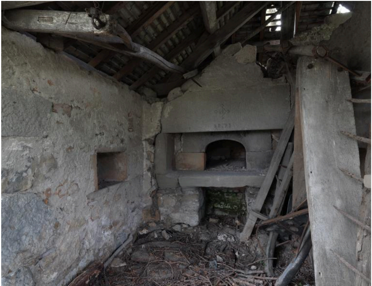
Vue d'ensemble intérieure du four à pain.
