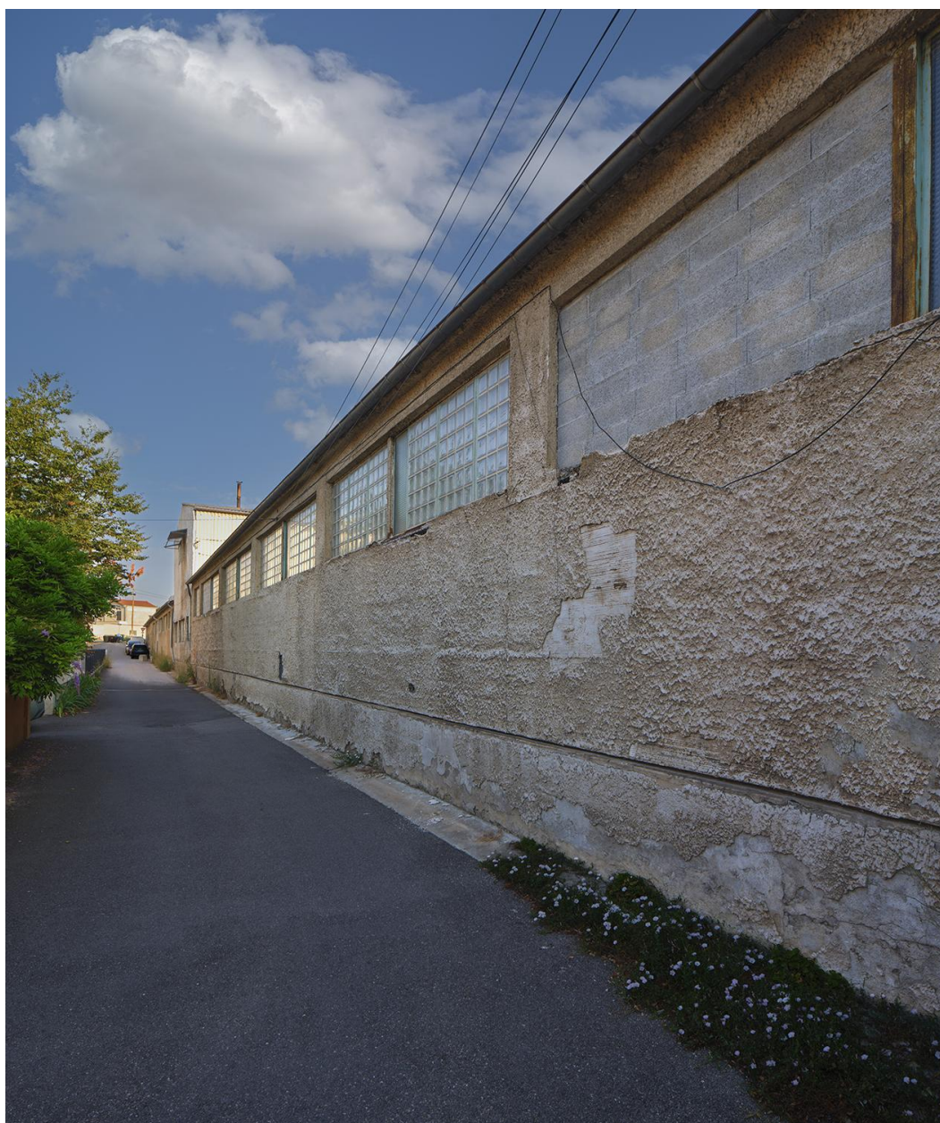
Façade est usine le Joint Lyonnais, Bron
