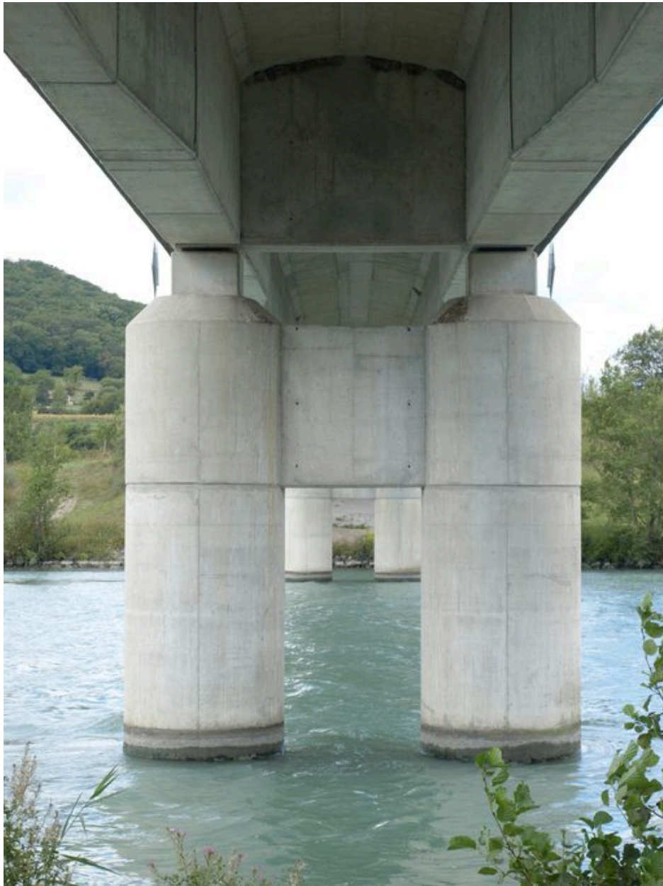
Pile, vue partielle (depuis la rive gauche)
