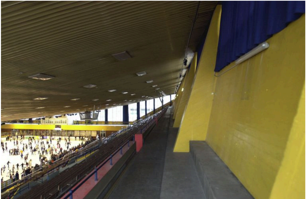
Pignon de la façade est : inclinaison intérieure
