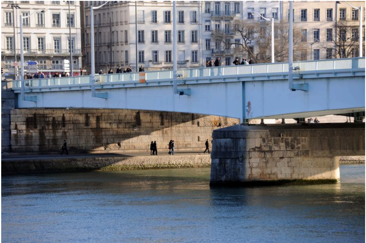
Vue partielle, travée gauche et culée, face amont (depuis la rive droite)
