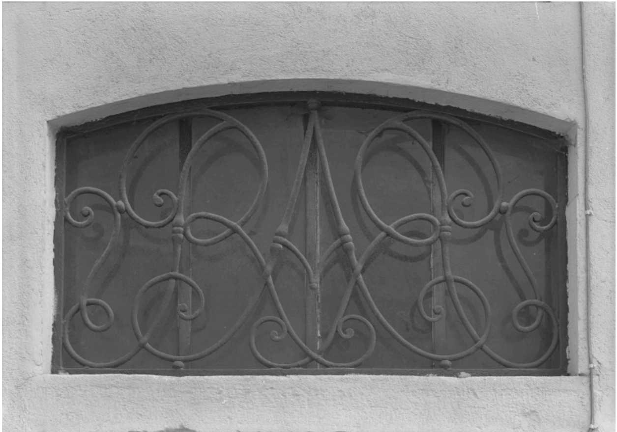
Détail de la façade principale.
