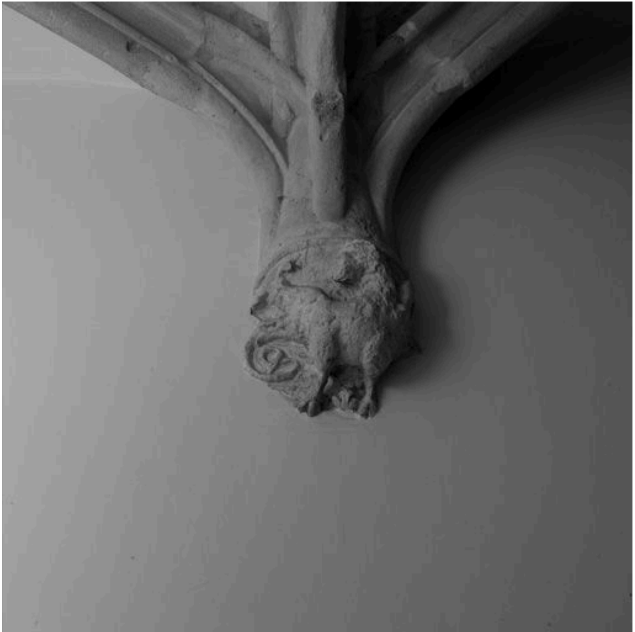
Voûte de l'allée, détail du culot 10
