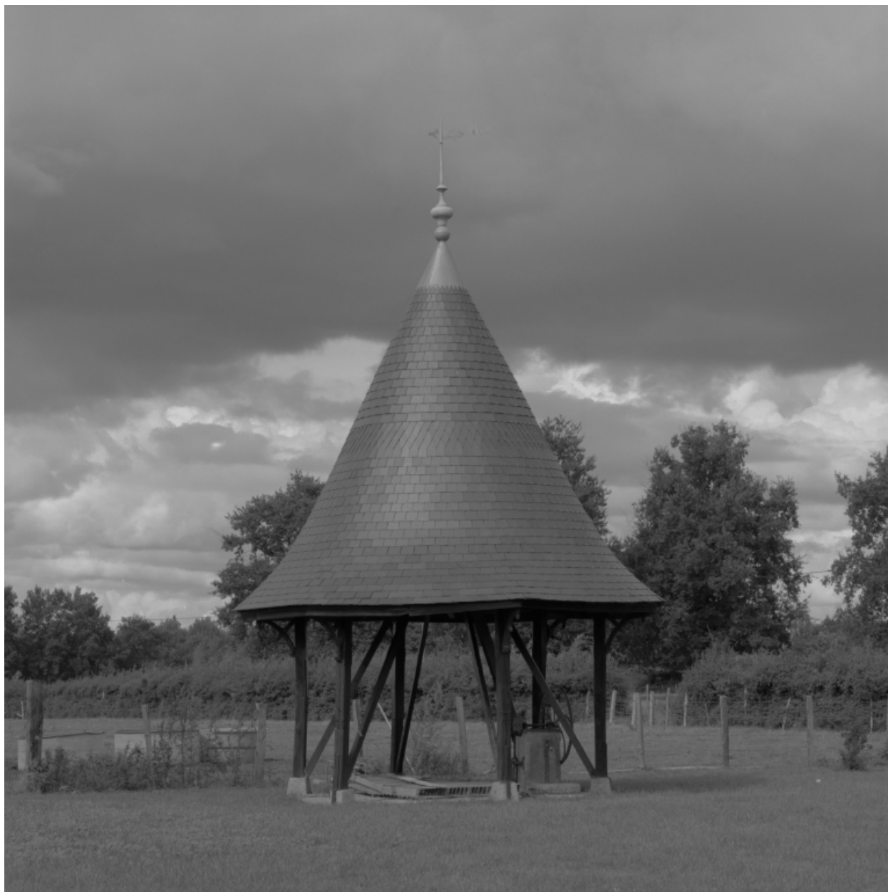
Vue d'ensemble du puits.
