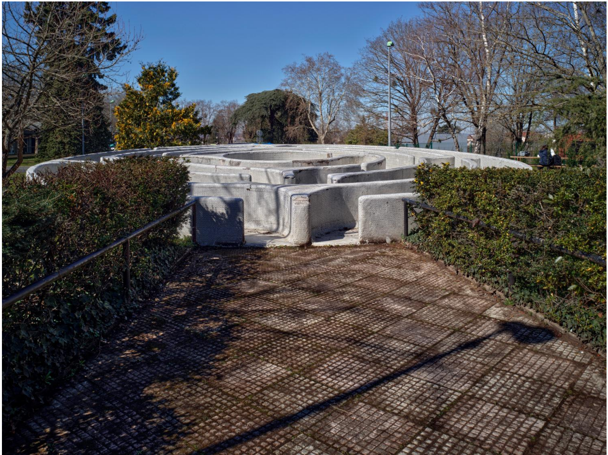
Vue depuis le niveau du sol
