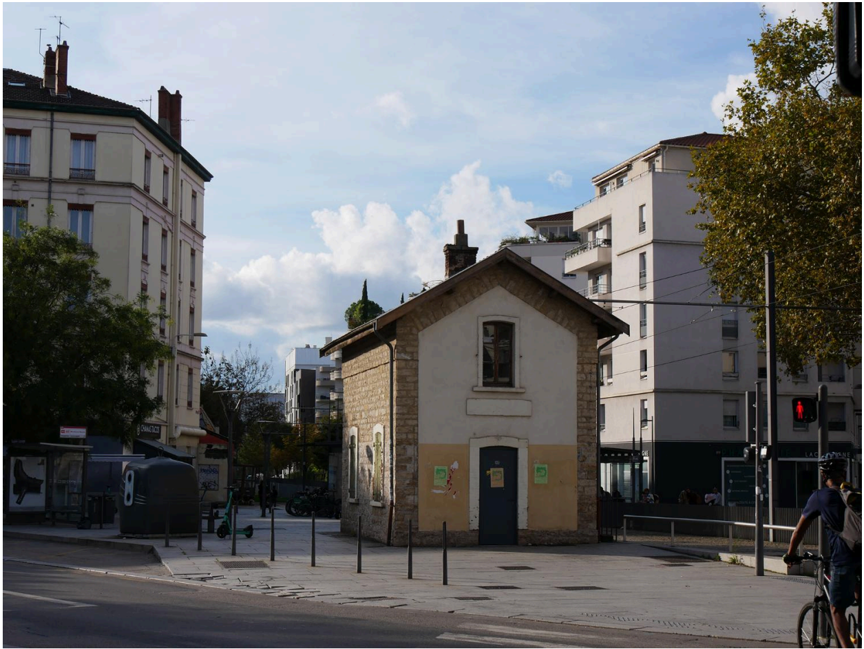
Maisonnette de passage à niveau de la ligne de l'Est, angle Dauphiné/Lacassagne
