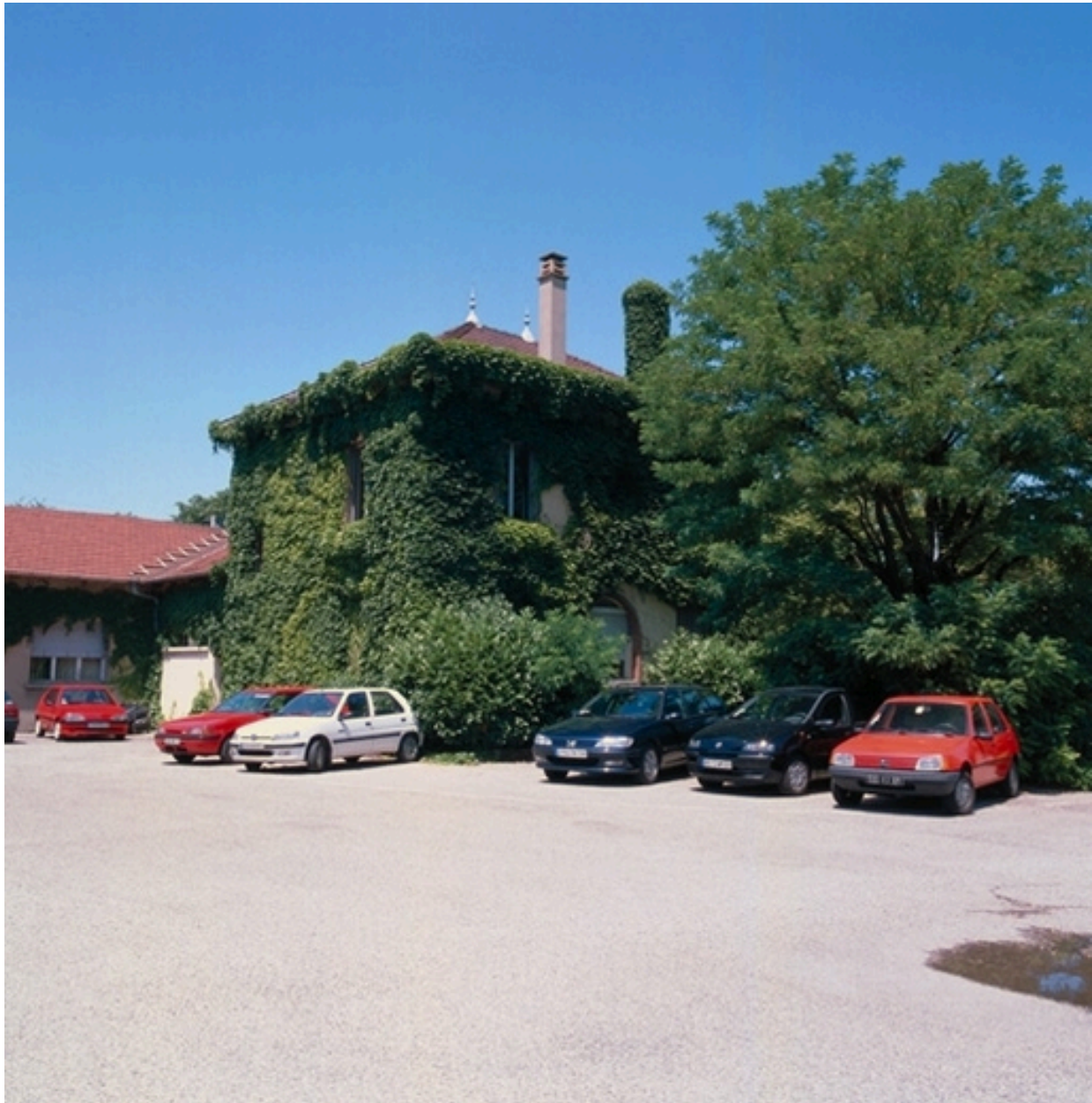
Vue d'ensemble sud de la ferme
