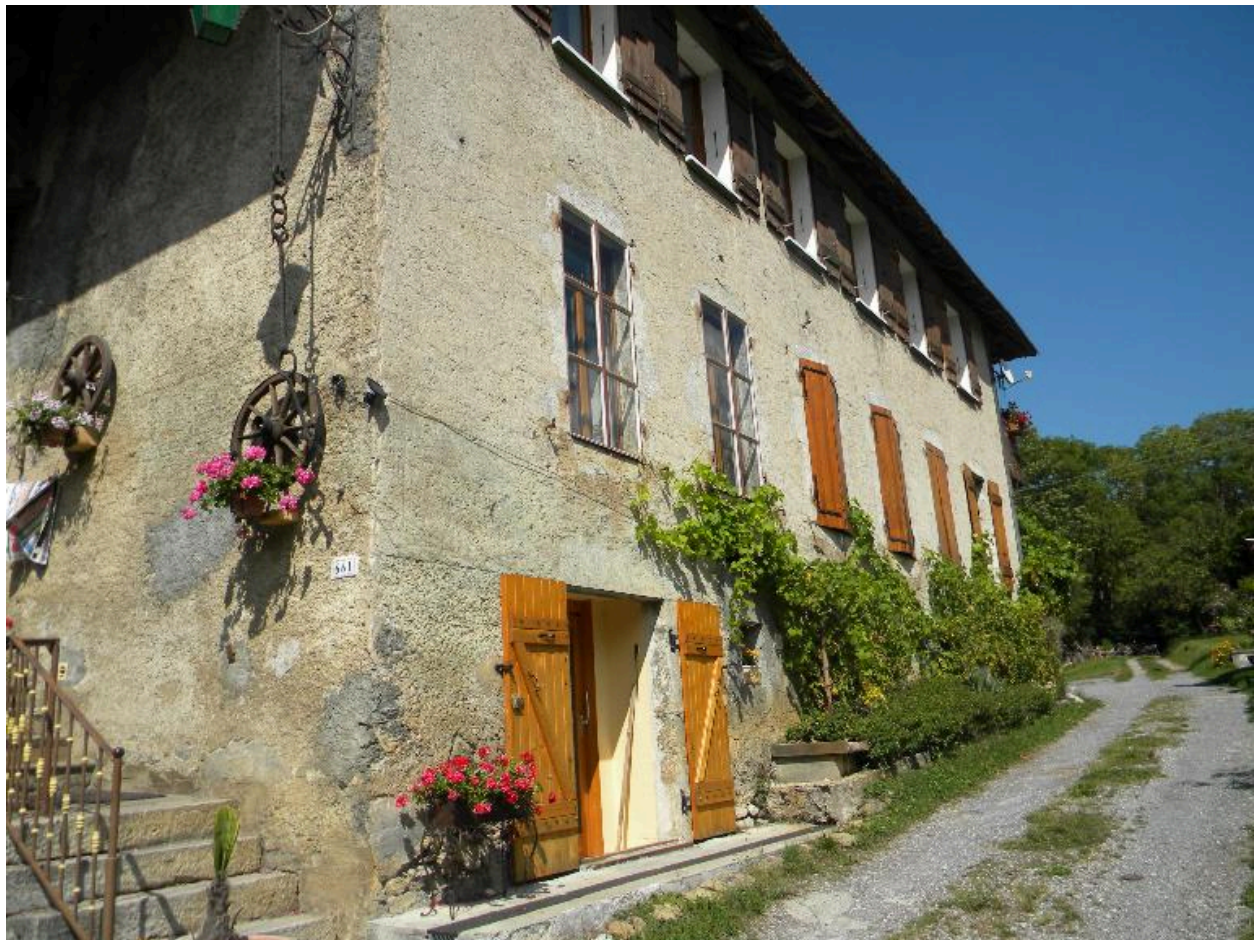
Façade principale de l'ancienne maison de maître.
