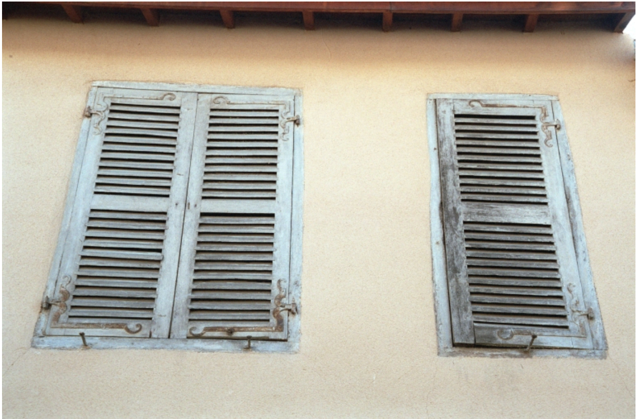
Boën, îlot 13, Ph. Raymond (rue) 28. Détail de la façade sur rue.
