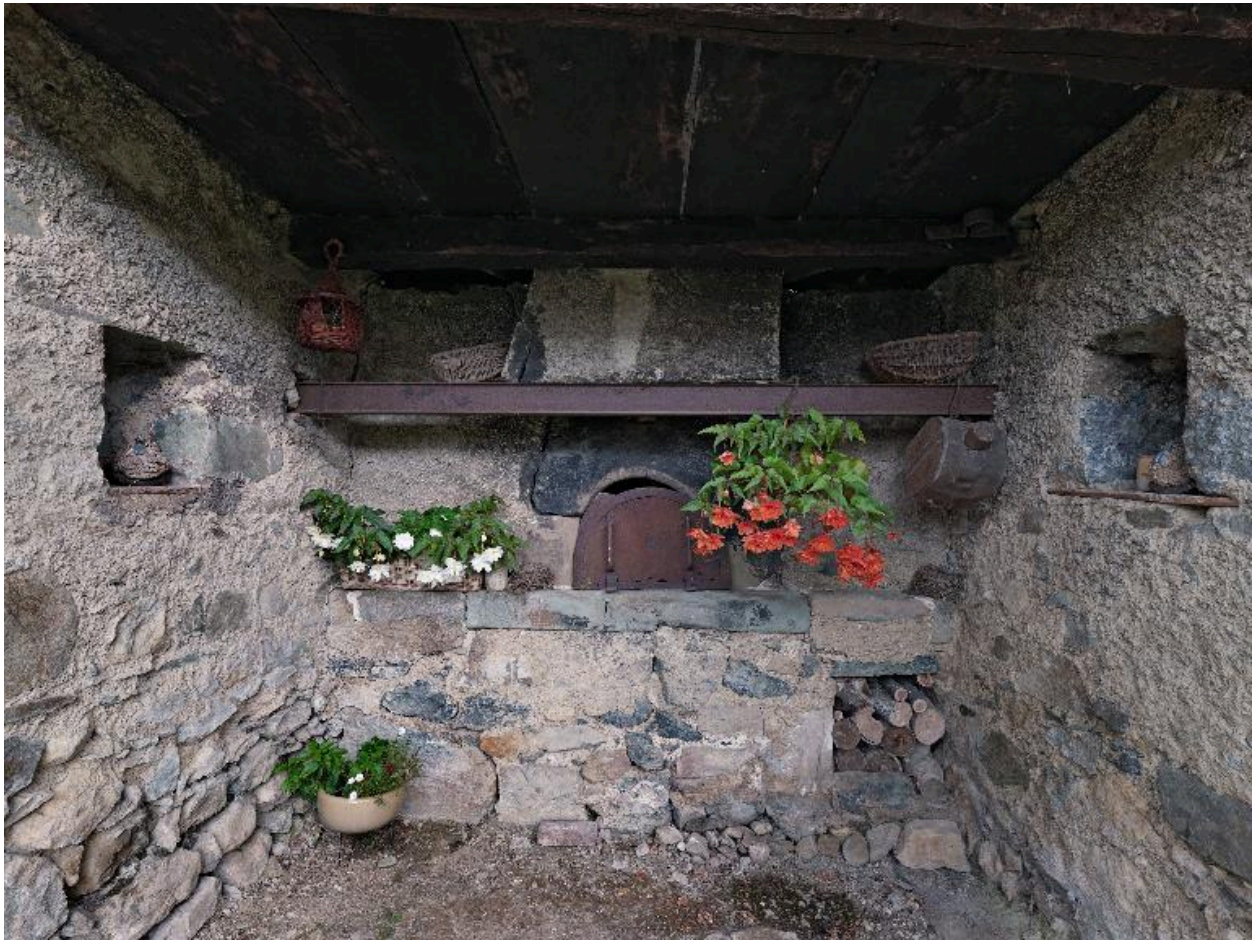
Vue d'ensemble intérieure du four à pain
