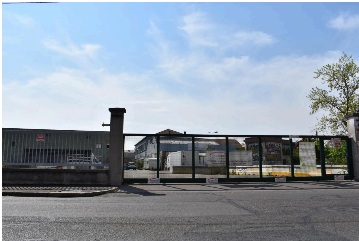
Véninov - vue de l'entrée de l'usine rue Eugène Maréchal
